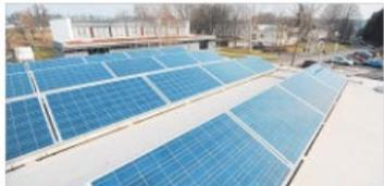
Fotovoltaikanlagen auf Haupthaus (28 kW<sub>p</sub>) und Wohnheim (12 kW<sub>p</sub>) tragen zur Deckung des Strombedarfs am Laubach-Kolleg bei.
